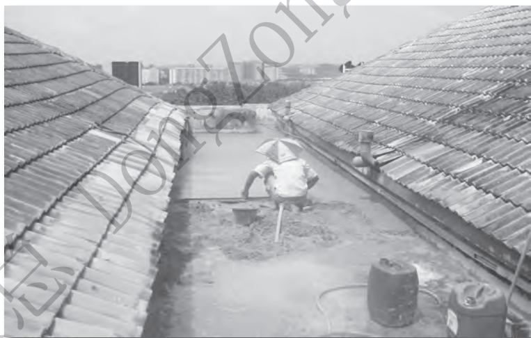
▶ 卸除天台中央冷气槽後 进行防水工程。
