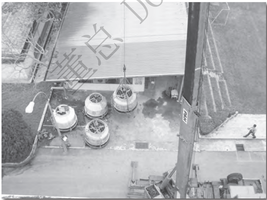
▲ 卸除天台中央冷气槽工程。
