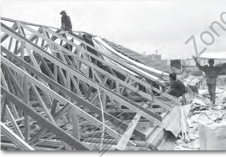
◀ A401会议室上方屋顶倾斜校正工程。
