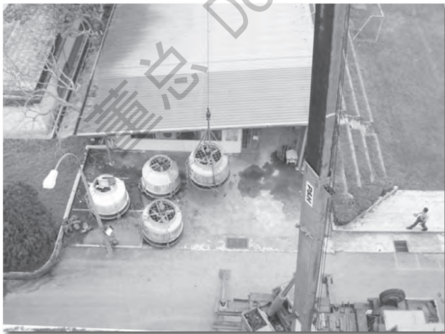
▲ 卸除天台中央冷气槽工程。
